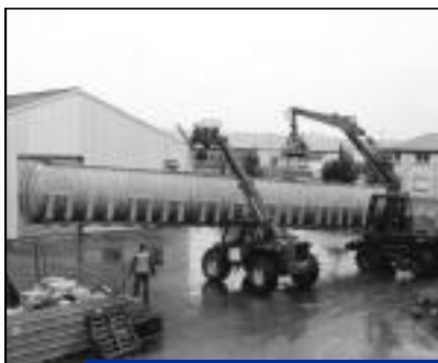
L'installation de cette cuve de 18 mètres a nécessité des moyens exceptionnels.
